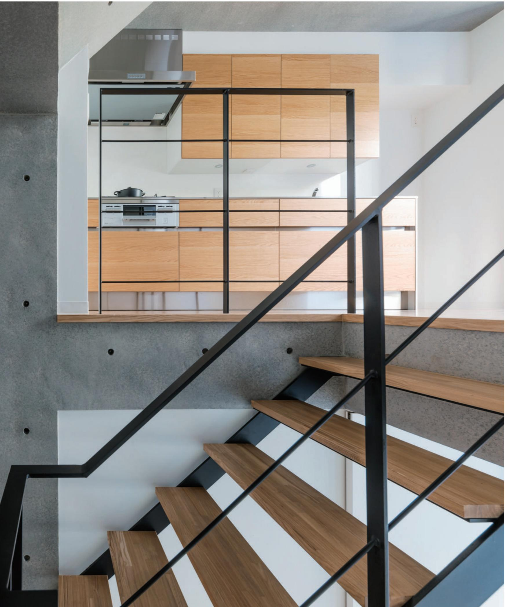
1階のダイニングキッチンと洋室。コンクリート打放し面のピーコン部は、穴埋せずに露出している。
